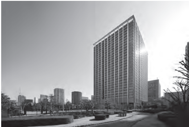
建物外観（北面景観）（撮影：フォワードストローク）
