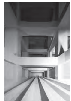
地下施設内観 （撮影：エスエス東京）
