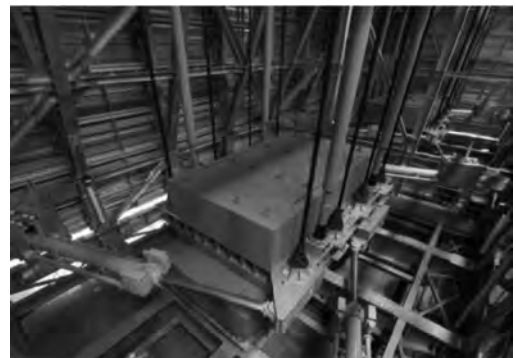
TMD 内観（撮影：鹿島建設）
