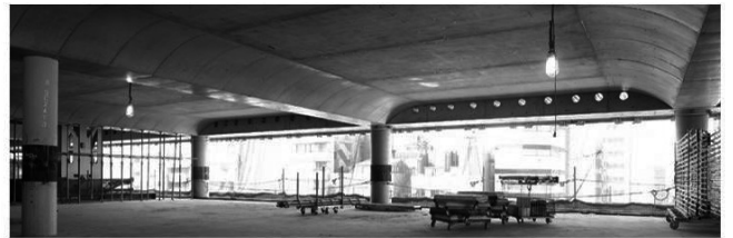
CFT柱とSRC大梁および一方向スラブ躯体（撮影：日建設）
