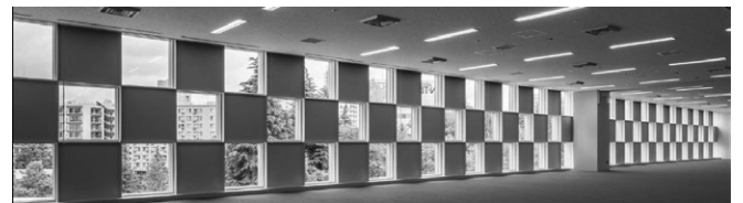
耐震格子パネル（事務室内観、撮影：川澄・小林研二写真事務所）
