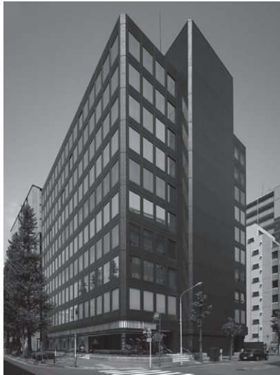
建物南西面外観 (1 階廻りの外装意匠を堅持)
