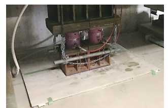
免震機能を維持するための仮設 （撮影：大林組）
