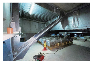
火器を用いない補強部材接合部 （撮影：NTT ファシリティーズ）
