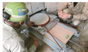
ジャッキアップレス工法
