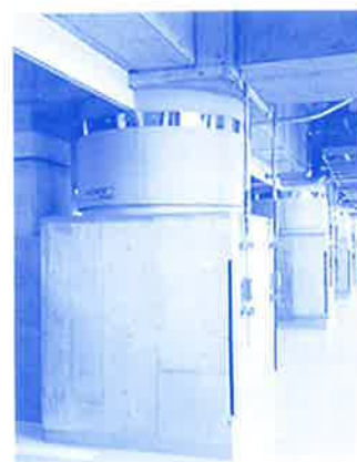
免震装置耐火被覆材 FIRE CATCH™
