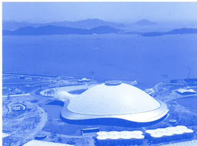
建物外観 (撮影：ナカサアンドパートナーズ)
