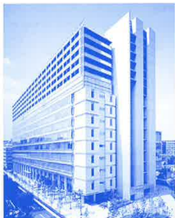
建物外観 1 (写真撮影: SS 東京)
