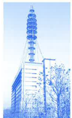
ドコモ大阪南港ビル
