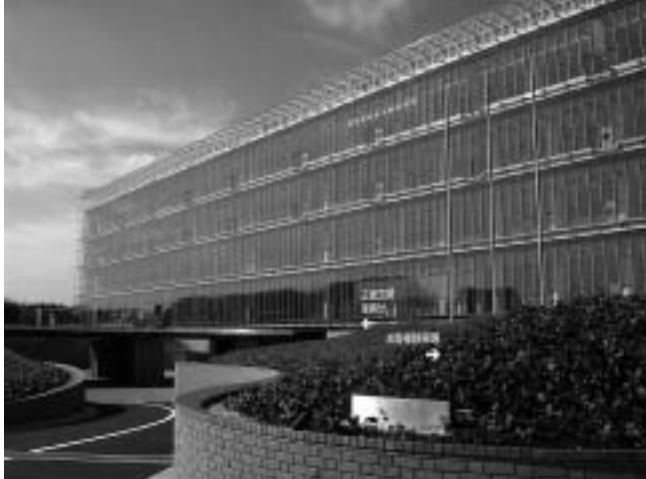
建物外観（南側・エントランス）
