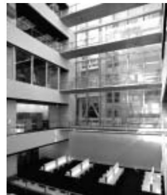
エキスパンションの無いアトリウム空間（撮影：大成建設）
