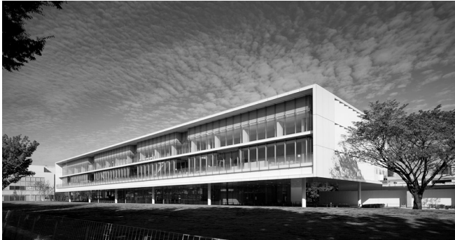
建物外観 (撮影：クドウフォト)
