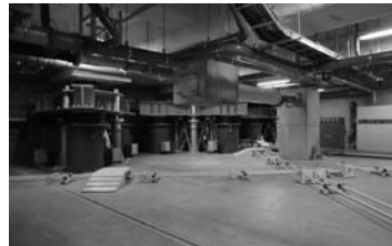
地下ピットの様子
