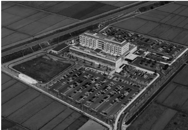
建物全景（撮影：小野俊次）
