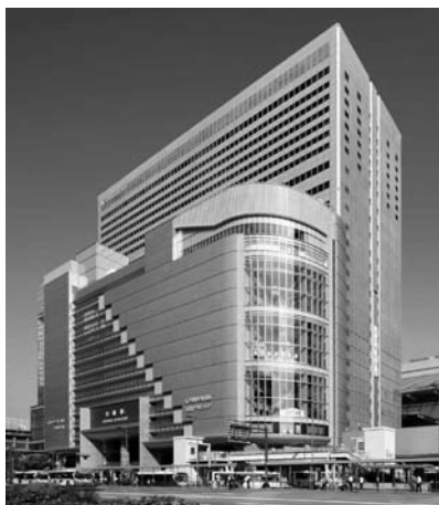
建物外観（撮影：竹中工務店）
