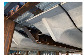
鉄骨大梁と PC- 鋼合成スラブ端部
